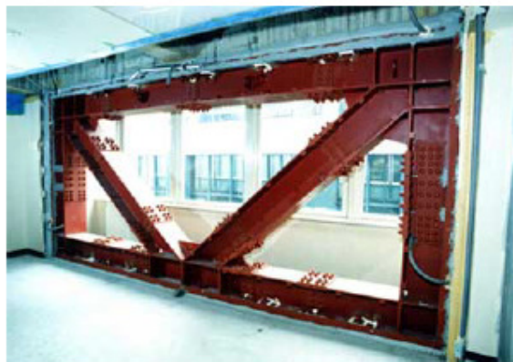
Σχήμα 2: Δικτυωτός σύνδεσμος μορφής ανεστραμμένου Λ [6]
