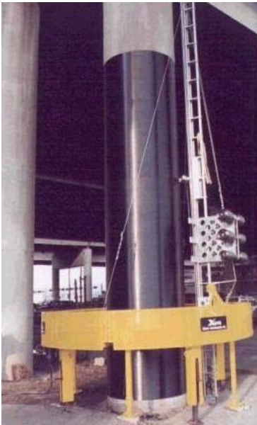
Εικόνα 2: Ενίσχυση με Robo-Warper
