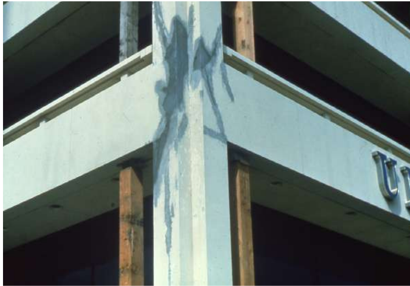
Σχήμα 1: Κόμβος μετά από ενίσχυση
