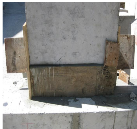
Φώτο 4. Απομάκρυνση παλαιού σκυροδέματος και καλούπωμα τοιχίου T 2
