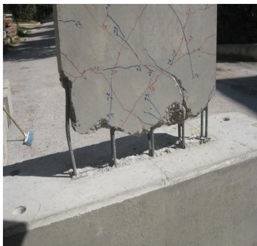
Φώτο 4. Απομάκρυνση παλαιού σκυροδέματος και καλούπωμα τοιχίου T 2
