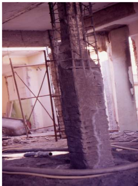
Εικόνα 9: Ολικός μανδύας από εκτοξευόμενο σκυρόδεμα. [2]
