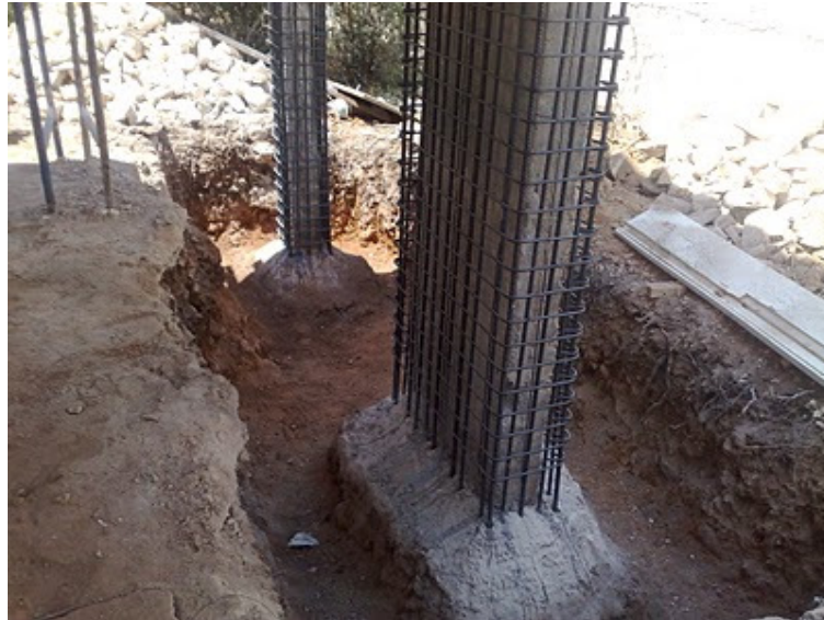
Εικόνα 10: Παράδειγμα αγκύρωσης οπλισμού υποστύλωματος πάνω σε πέδιλο. [6]
