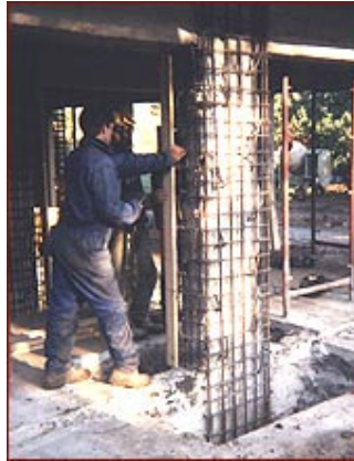
Εικόνα 7: Τοποθέτηση καλουπιών. [5]
