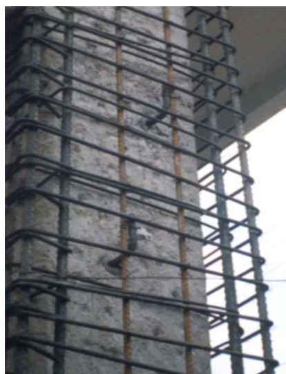
Εικόνα 2: Υποστύλωμα μετά την τοποθέτηση του νέου οπλισμού [2].
