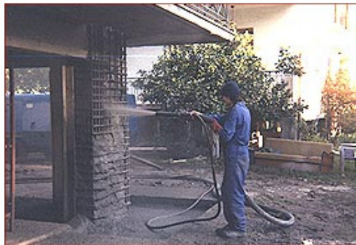
Εικόνα 8: Χρήση εκτοξευόμενου σκυροδέματος. [5]
