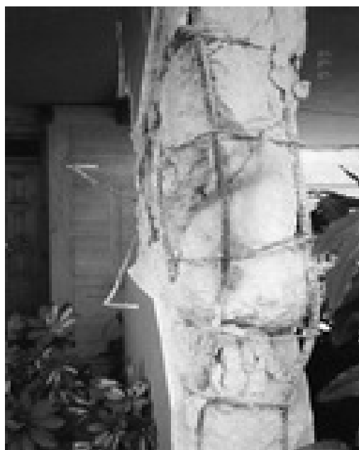
Εικόνα 3: Διακοπή συνέχειας υποστυλώματος λόγω πλήρους αποδιοργάνωσης του σκυροδέματος και βλάβης του διαμήκους και του εγκάρσιου οπλισμού. [3]
