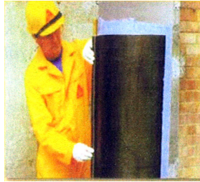
Εικόνες 1 και 2: Ενίσχυση υποστυλωμάτων με FRP. [8]
