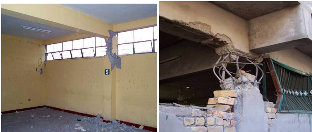
Σχήμα 1: Συνήθης τρόπος σχηματισμού και αστοχίας κοντών υποστυλωμάτων [5]
