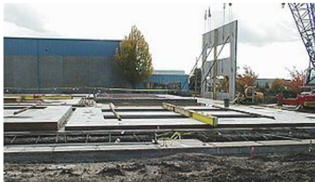
Σχήμα 4: Κτίριο τύπου Tilt-Up [8]
