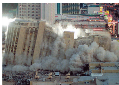
Σχήμα 10: Εσωτερική κατεδάφιση Las Vegas, U.S.A. 1998
