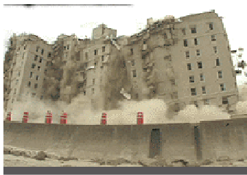
Σχήμα 13: Σύγκρουση τμημάτων πριν την πτώση
