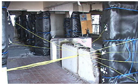
Σχήμα 16: Καλύμματα πυροδοτούμενων υποστρωμάτων.
