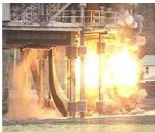
Σχήμα 15: Μεταλλικό υποστύλωμα που κόβεται στη μέση με τη χρήση RDX [14]
