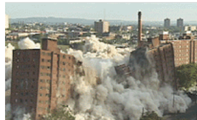
Σχήμα 14: Θραύση τμημάτων κατά την πτώση
