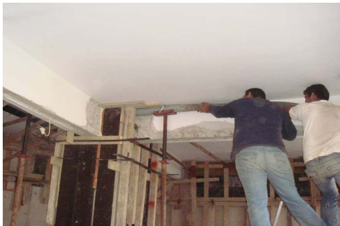
Εικόνες 15, 16, 17, 18: 2ο στάδιο επισκευής κατασκευής με SCC [3]
