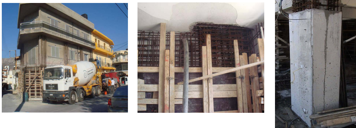
Εικόνες 12, 13, 14: 1 ο στάδιο επισκευής κατασκευής με SCC [3]
