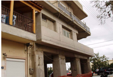
Εικόνες 19,20: 3ο στάδιο επισκευής κατασκευής με SCC [3]
