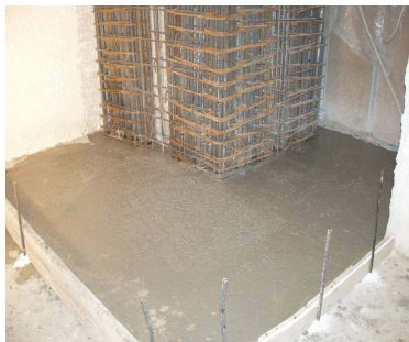
Εικόνες 31, 32, 33, 34: Ενίσχυση υποστυλώματος (μανδύες) και θεμελίωσης με SCC [3]
