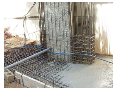
Εικόνες 31, 32, 33, 34: Ενίσχυση υποστυλώματος (μανδύες) και θεμελίωσης με SCC [3]
