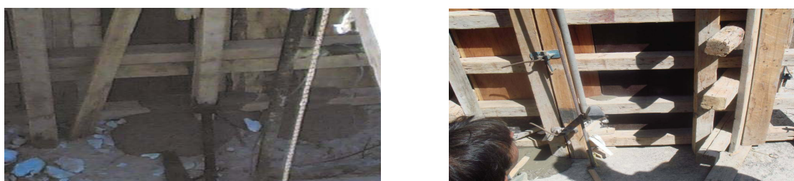
Εικόνες 10,11: Παραδείγματα μη – στεγανότητας ξυλοτύπων [3]
