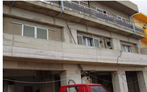
Εικόνες 19,20: 3ο στάδιο επισκευής κατασκευής με SCC [3]
