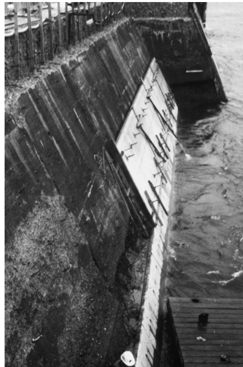
Εικόνα 5.1: Στάδιο τοποθέτησης πάνελ σε φράγμα του ποταμού Troy Lock [11]
