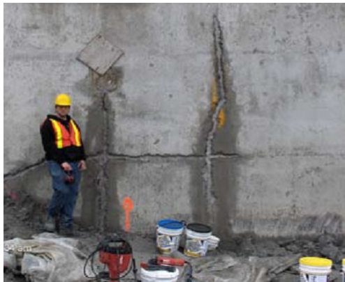
Εικόνα 4.4: Επισκευή ρωγμών του φράγματος Coquitlam [5]
