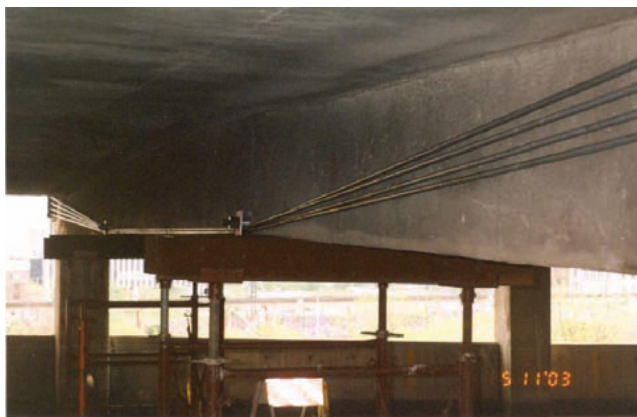
Σχήμα 2: Ενίσχυση δοκού με εξωτερικό τένοντα 2 στηρίξεων[7]
