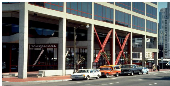
Σχήμα 1: Χρήση δικτυωτού χιαστί συνδέσμου σε πολώροφο κτίριο [12]
