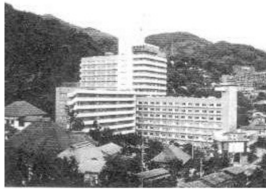
Εικόνα 11 Εξωτερική Όψη της κατασκευής
