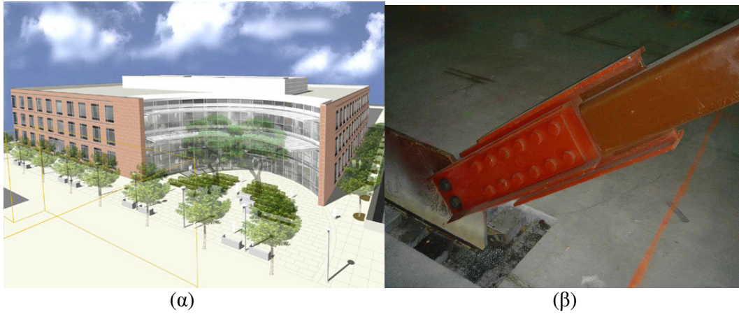
Σχήμα 17 α) Monterey County Government Center β) διαγώνιος αποσβεστήρας τριβής
