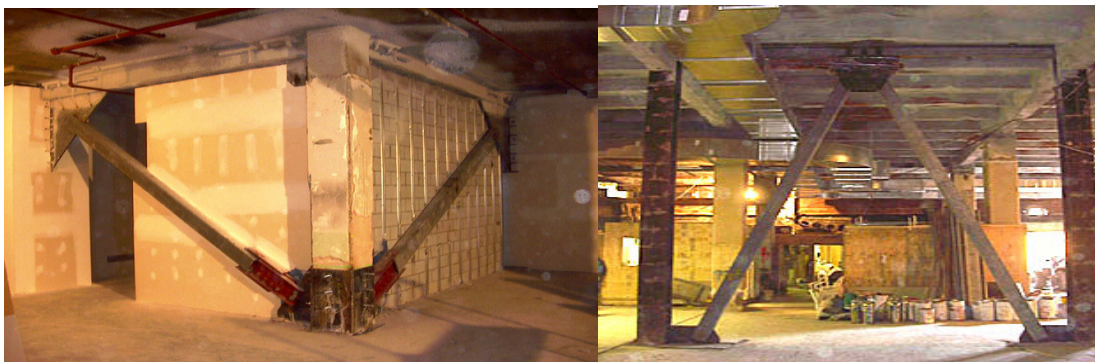
α) β) Σχήμα 13. α) μονά διαγώνια στοιχεία απόσβεσης β) αποσβεστήρας σε διάταξη Λ(τύπου Chevron)
