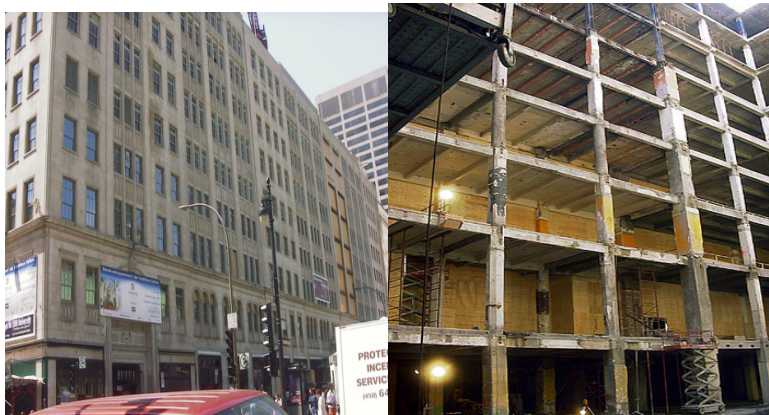
(α) (β) Σχήμα 12. α) Eaton building β) όψη από το αίθριο κατά την κατασκευή
