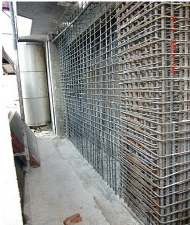
Σχήμα 1. Κατασκευή τοιχώματος σε υπάρχουσα κατασκευή [1]
