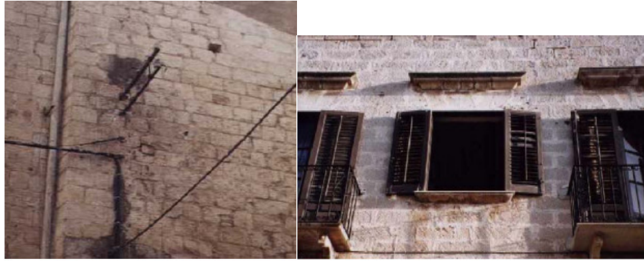
Σχήμα 2. Παράδειγμα τοιχοποιίας τύπου II : κανονική (λαξευμένη) δομή και καλή ποιότητα υλικών [1]
