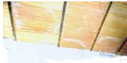
Σχήμα 5. Ξύλινα πατώματα με κάθετα στρώματα από τάβλες, πατώματα από προκατασκευασμένα οπλισμένα κεραμικά δοκάρια ή από κεραμικά στηριζόμενα σε σιδερένιες δοκούς και σκυρόδεμα. [1]
