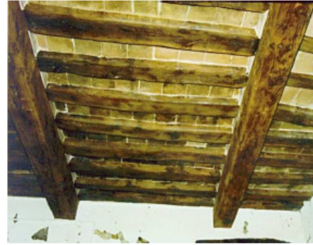
Σχήμα 3. Ξύλινο πάτωμα με μονής ή διπλής διεύθυνσης δοκάρια, με τούβλα ή ξύλινες τάβλες και μη συνεκτικά υλικά για γέμισμα κάτω από την πλάκα. [1]
