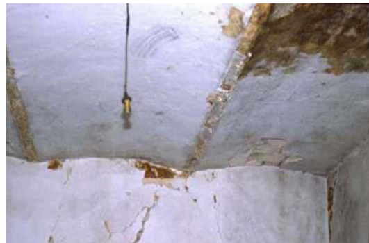
Σχήμα 4. Πάτωμα με αψίδες από τούβλα ή σκυρόδεμα στηριζόμενες σε σιδερένιες δοκούς. [1]
