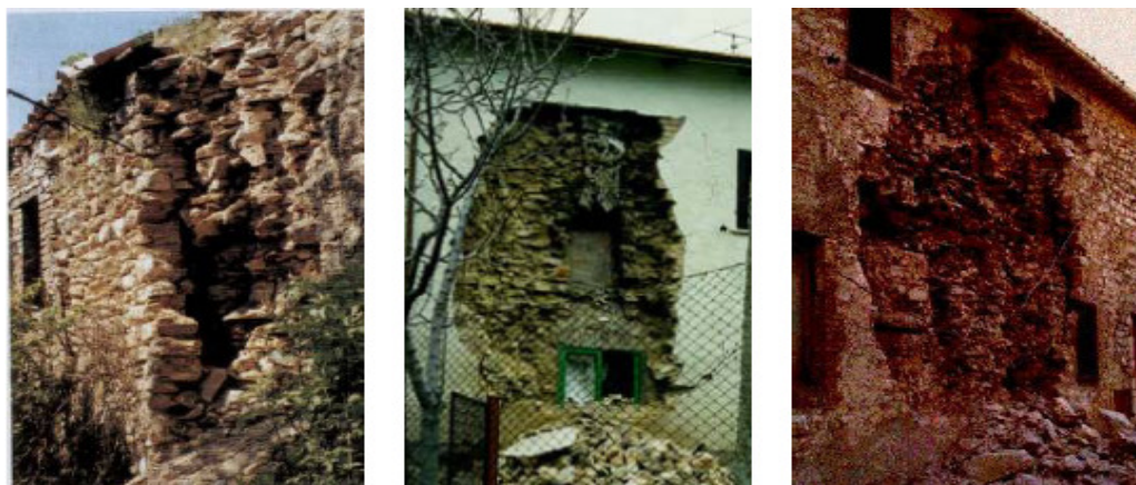
Σχήμα 1. Παράδειγμα τοιχοποιίας τύπου Ι : ακανόνιστη -μη λαξευμένη- δομή ή υλικά χαμηλής ποιότητας [1]
