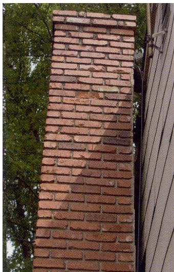
Σχήμα 3: Αποκόλληση καμινάδας[5]
