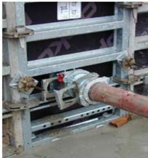
Σχήμα 11. Λεπτομέρεια σκυροδέτησης μέσω εισπίεσης [11]
