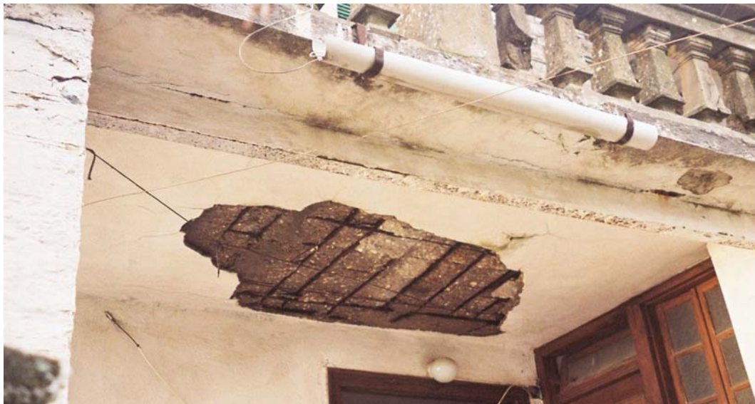
Εικόνα 2: τοπική διάβρωση
