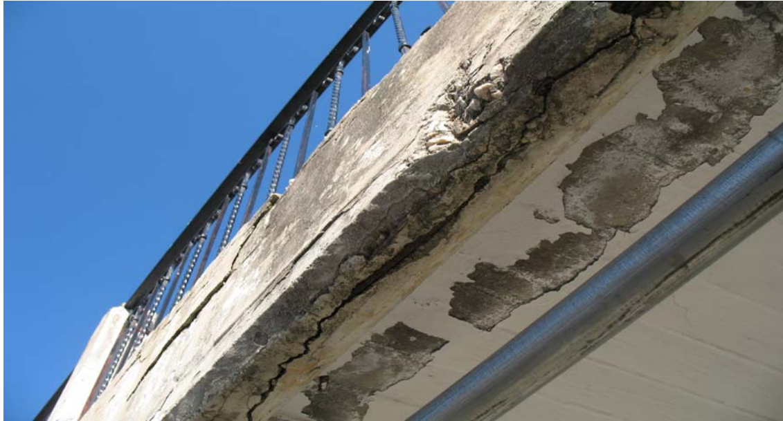
Εικόνα 1: ομοιόμορφη διάβρωση
