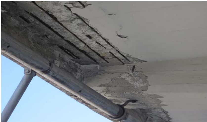
Εικόνα 5: διαβρωμένη πλάκα
