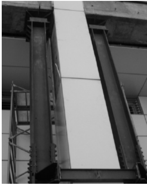
Σχήμα 6: Προσωρινή υποστήριξη με μεταλλικά υποστυλώματα [8]
