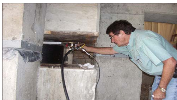
Σχήμα 5: Εγκατάσταση σεισμικού μονωτήρα [7]
