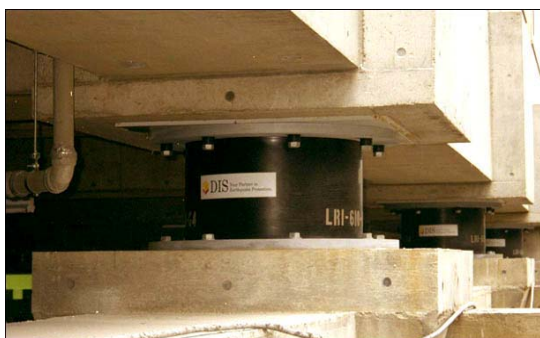
Σχήμα 4: Σεισμικός μονωτήρας [7]
