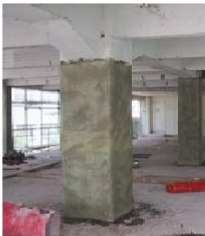
Εικόνα 2. Περίσφιγξη με ολόσωμο μανδύα από FRP [8]
