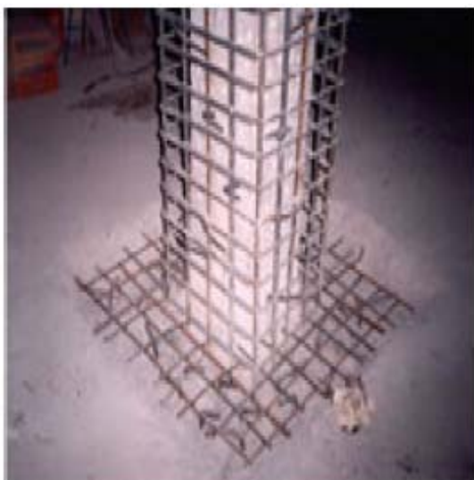
Εικόνες 3, 4. Ενίσχυση με ολικό μανδύα οπλισμένου σκυροδέματος [9]
