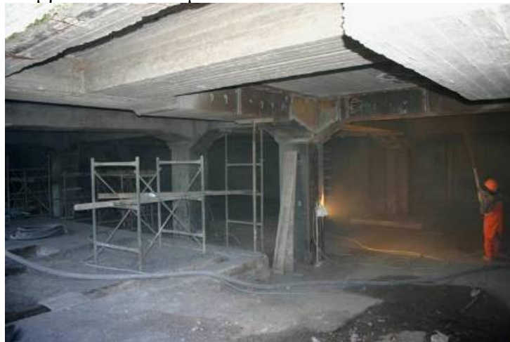
Σχήμα 3: Εκτόξευση σκυροδέματος σε οριζόντια επιφάνεια οροφής
