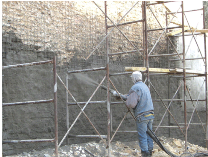
Σχήμα 4: Εκτόξευση σκυροδέματος σε κατακόρυφη επιφάνεια [4]
