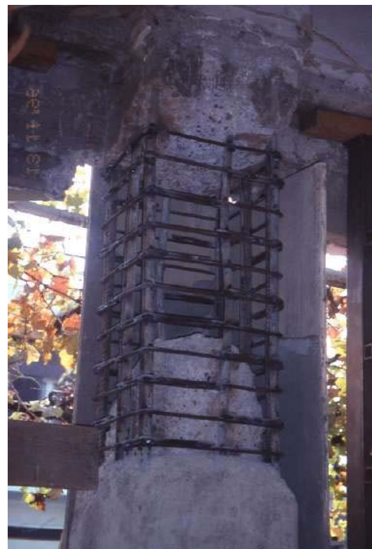
Σχήμα 8 : Επισκευή Υποστυλώματος [4]
