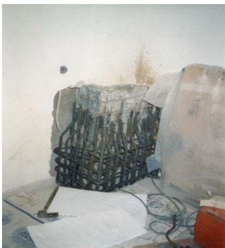
Σχήμα 9 : Επισκευή Υποστυλώματος [4]
