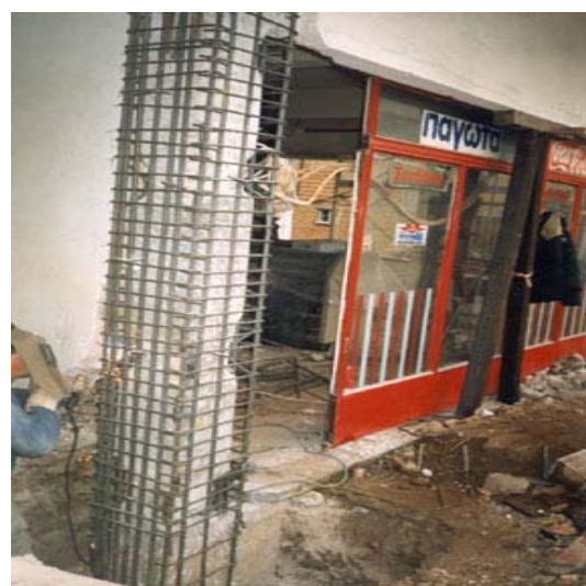
Σχήμα 10 : Επισκευή- Ενίσχυση Υποστυλώματος [4]
