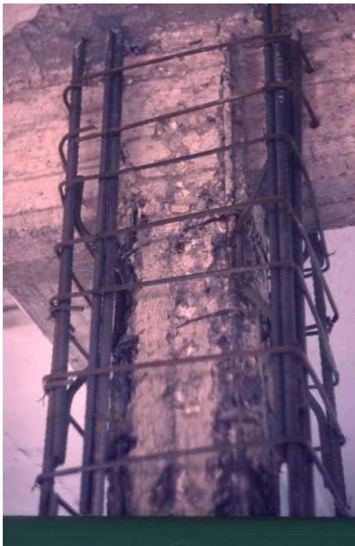
Σχήμα 7 : Ενίσχυση Υποστυλώματος [4]
