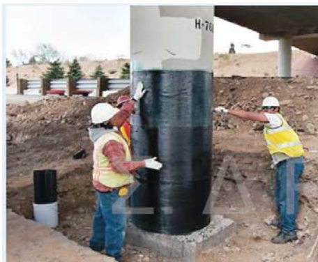
Εικόνα 3:Ενίσχυση υποστυλώματος με ΙΟΠ(FRP's) [8]
