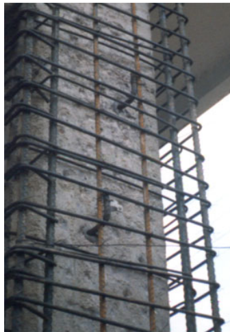
Εικόνα 4:Ενίσχυση υποστυλώματος με μανδύα οπλισμένου σκυροδέματος [8]
