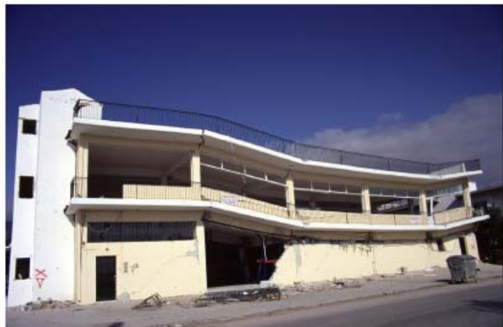
Εικόνα 2β: Αστοχία σειράς κοντών υποστυλωμάτων
