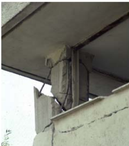
Εικόνα 2α: Αστοχία κοντού υποστυλώματος
