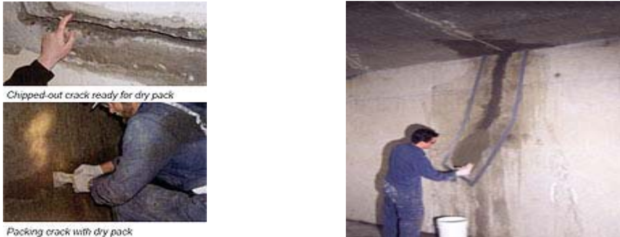
Εικόνα 7 : Μέθοδος των τσιμεντοκονιαμάτων [9]
