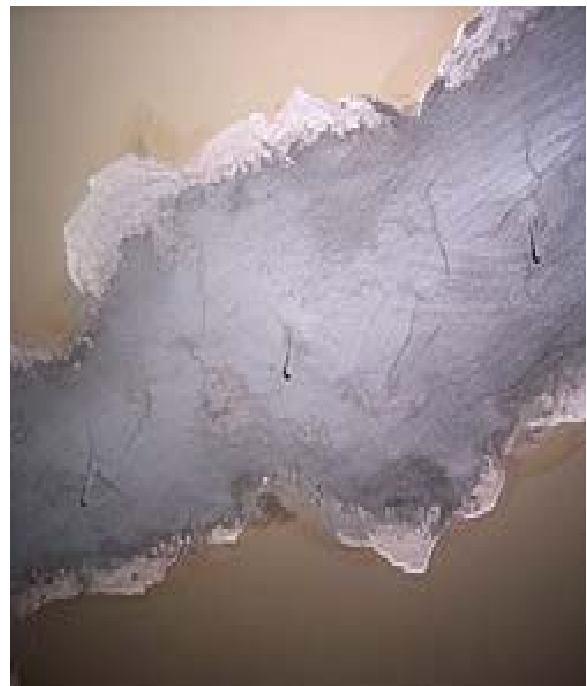
Εικόνα 4 : Διαδικασία εφαρμογής της μεθόδου των ρητινενέσεων [10]
