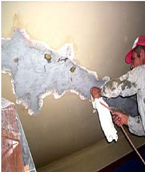
Εικόνα 4 : Διαδικασία εφαρμογής της μεθόδου των ρητινενέσεων [10]
