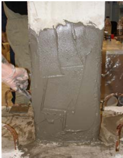
Εικ.2: Επάλειψη Επιφάνειας με Κονίαμα [5]
