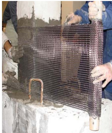
Εικ. 3: Περιτύλιξη Πλέγματος [5]
