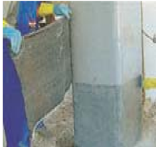
Σχήμα 3. Τοποθέτηση μανδυνών από σύνθετα υλικά σε υποστρώματα [8]
