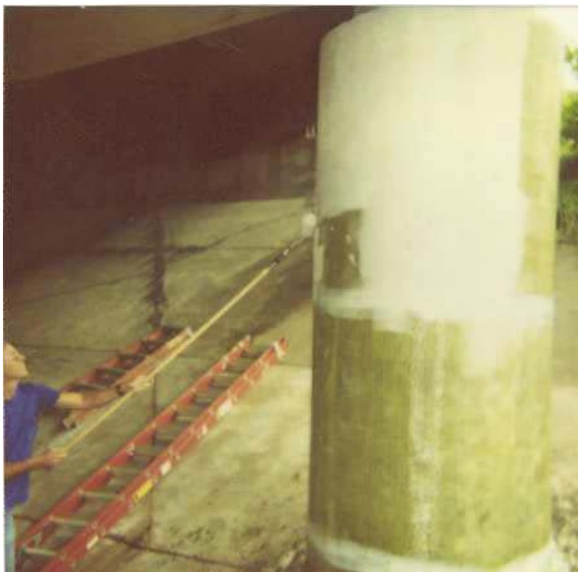
Σχήμα 4. Προετοιμασία εφαρμογής τοποθέτησης μανδυνών σύνθετων υλικών σε υποστύλωμα [10]
