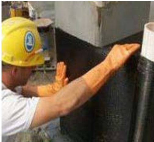
Σχήμα 3. Τοποθέτηση μανδυνών από σύνθετα υλικά σε υποστρώματα [8]
