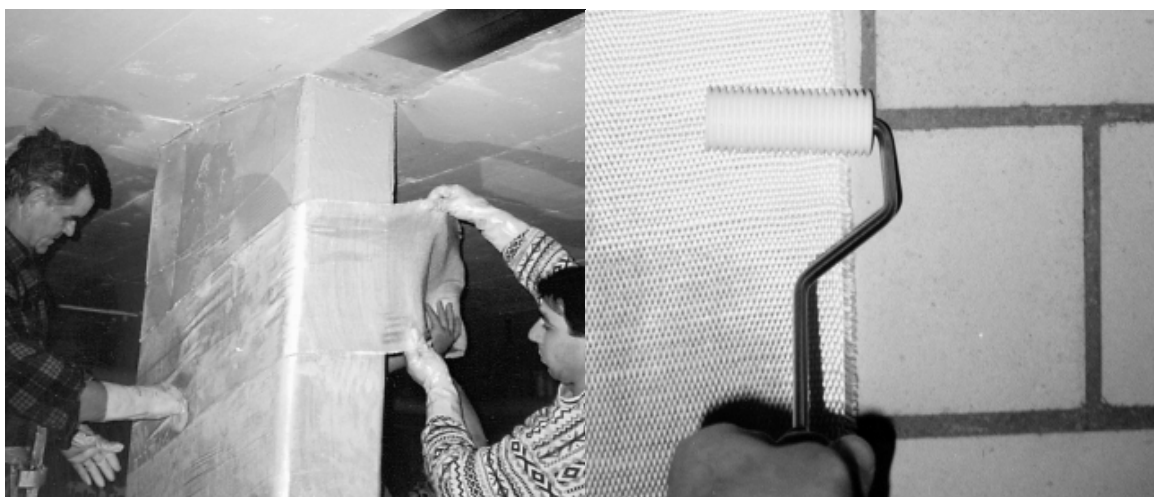
Σχήμα 5. α) Τοποθέτηση υφάσματος σύνθετου υλικού , β) Πλαστικό ρολό για σωστή συνένωση επιφάνειας-σύνθετου υλικού [9]
