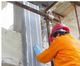
Σχήμα 8: Τοποθέτηση διαμήκους οπλισμού [3]
