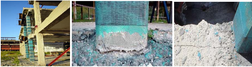
Σχήμα 9: Βασικές βλάβες της ενισχυμένης κατασκευής [3]
