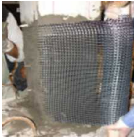
Σχήμα 4: Εφαρμογή ινοπλεγμάτων σε κονίαμα σε βάση υποστρώματος [2]
