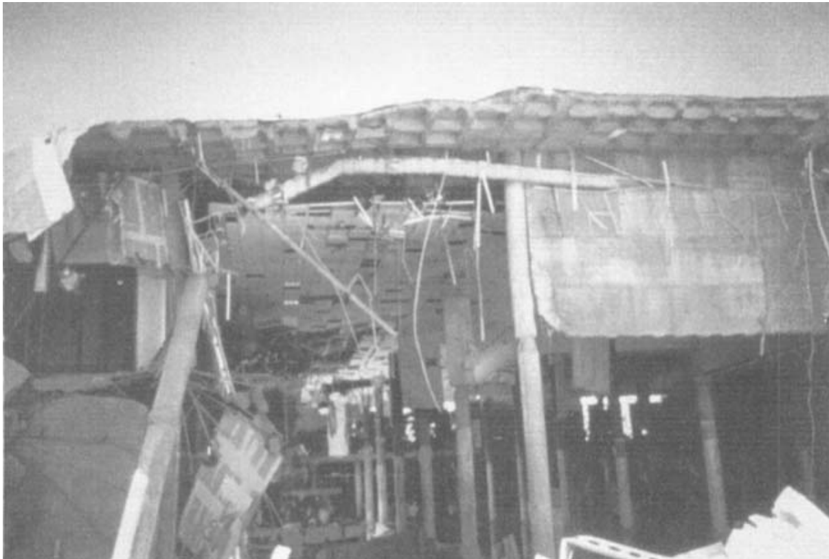
Σχήμα 7: Κατάρρευση των δύο ανώτερων μυκητοειδών πλακών, Bullocks store [30]
