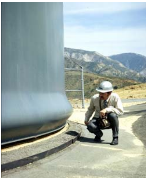
Σχήμα 14: Αστοχία δεξαμενών λόγω της κατακόρυφης και της οριζόντιας εδαφικής επιτάχυνσης [24]
