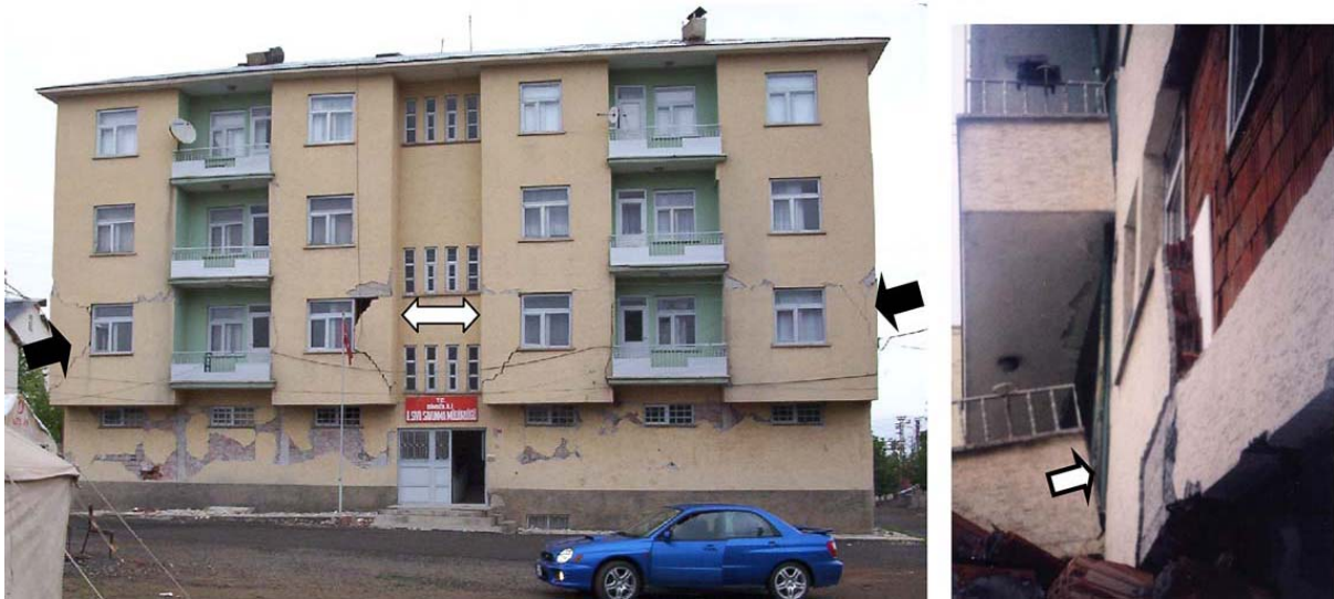
Σχήμα 8: Βλάβες σε μπαλκόνια, Bingol, Τουρκία [15]
