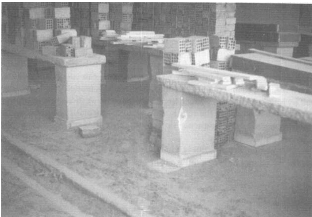
Σχήμα 1: Πάγκος που έχει μετακινηθεί χωρίς ίχνη τριβής στο δάπεδο [30]
