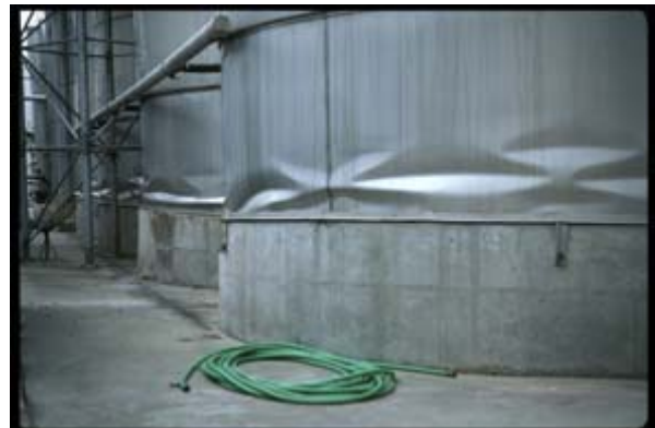
Σχήμα 14: Αστοχία δεξαμενών λόγω της κατακόρυφης και της οριζόντιας εδαφικής επιτάχυνσης [24]
