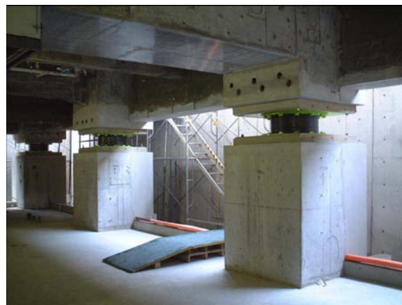
Ολοκλήρωση σεισμικής μόνωσης[6]
