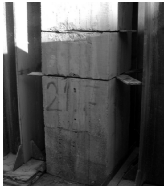
Κοπή υπάρχοντος υποστυλώματος [6]
