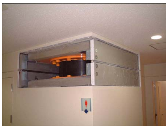
Τοποθέτηση μονωτήρα σε πυροπροστατευτικό πίνακα[6]
