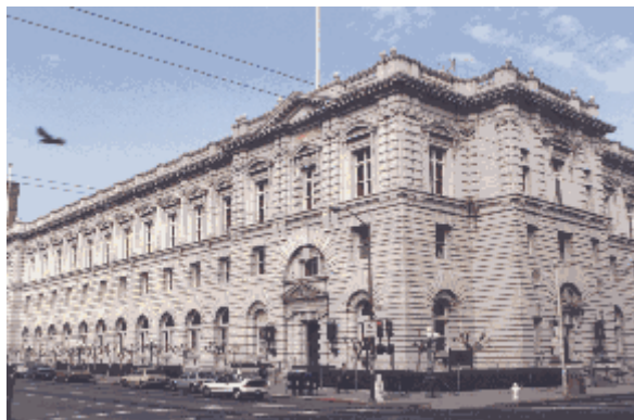
Όψη Court of Appeals στο San Francisco[12]
