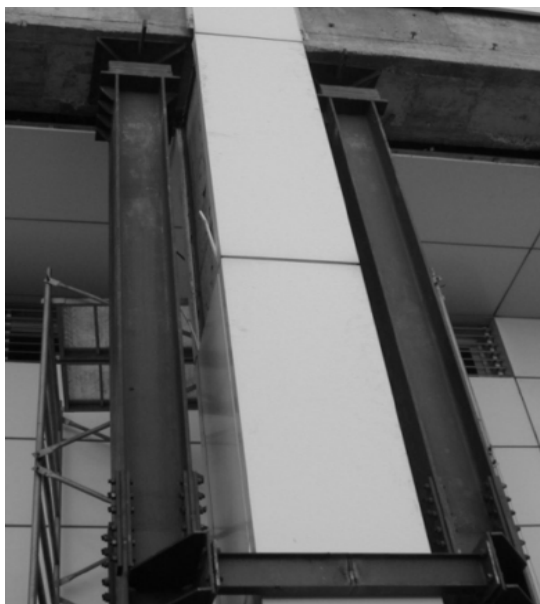
Τοποθέτηση προσωρινών υποστυλωμάτων [6]
