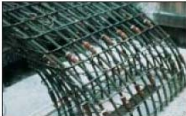
Σχήμα 12: Ένωση καμπύλων ράβδων με Cadweld [8]
