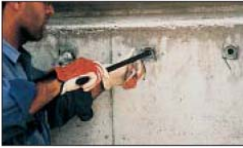
Σχήμα 9: Τοποθέτηση νέας ράβδου σε starter bar system της Lenton(Form Saver) [8]
