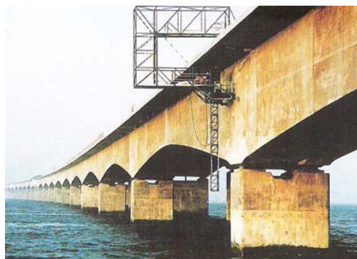
Σχήμα 30: Γέφυρα Storebaelt West στη Δανία [8]
