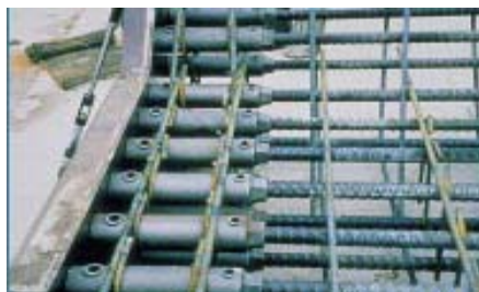
Σχήμα 15: Εφαρμογή του Interlock της Lenton [8]
