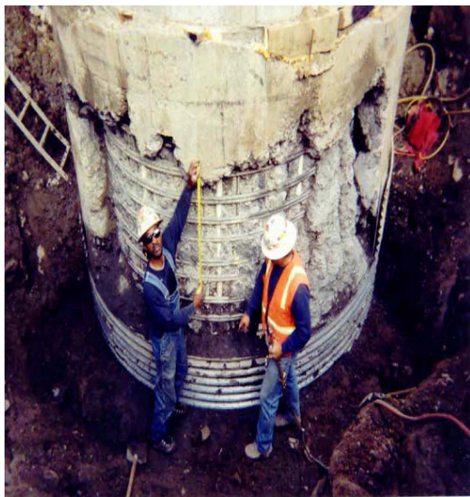
Εικόνες 22, 23 – Αποτελέσματα ύστερα από κακή σκυροδέτηση και δόνηση [4]
