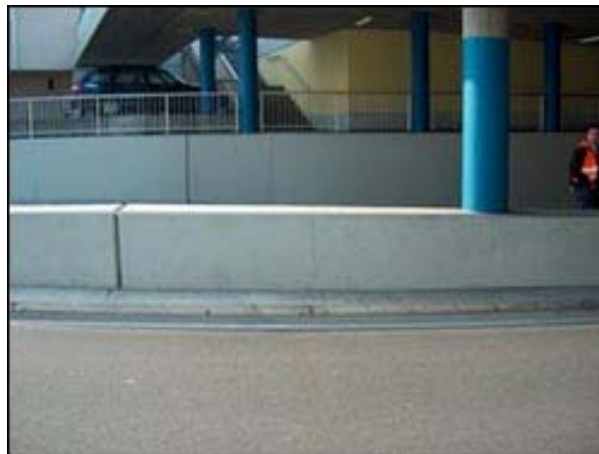
Εικόνα 8 – Μετά την επισκευή με ενισχυμένο ΑΣΣ [13]
