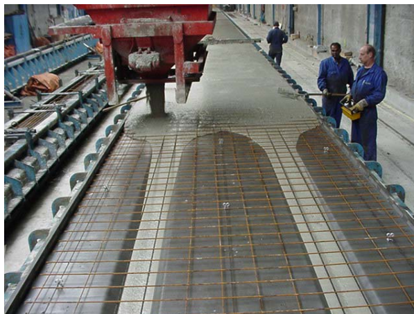
Εικόνα 14 – Σκυροδέτηση προκατασκευασμένου στοιχείου με ΑΣΣ [10]
