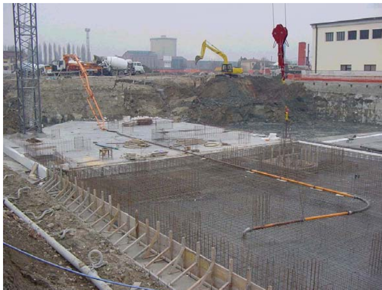
Εικόνα 19 - Σκυροδέτηση πλάκας με ΑΣΣ σε Εμπορικό κέντρο στη Ferrara της Ιταλίας [10]
