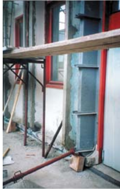
Εικόνα 10 – Μετά την αποκατάσταση[3]
