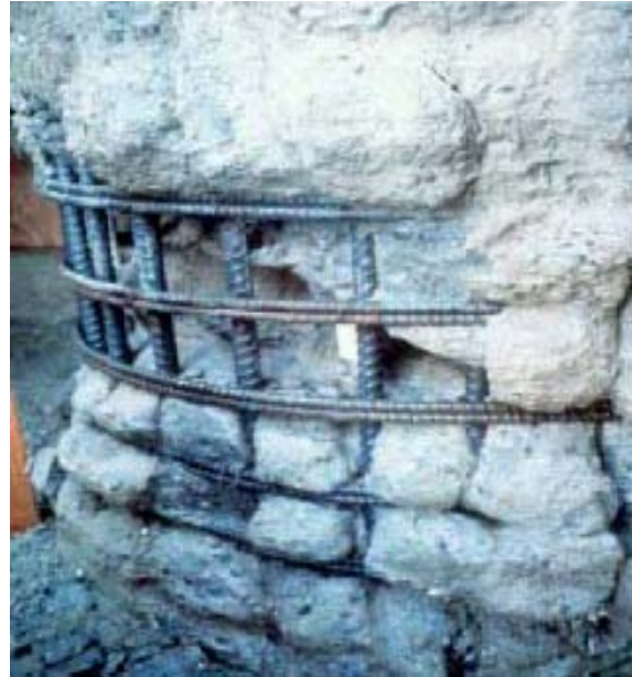
Εικόνες 20, 21 – Αποτελέσματα ύστερα από κακή σκυροδέτηση και δόνηση [4]
