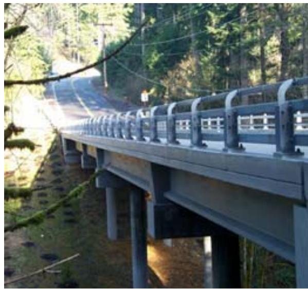
Εικόνα 4- Γέφυρα Wynaco, King [1]
