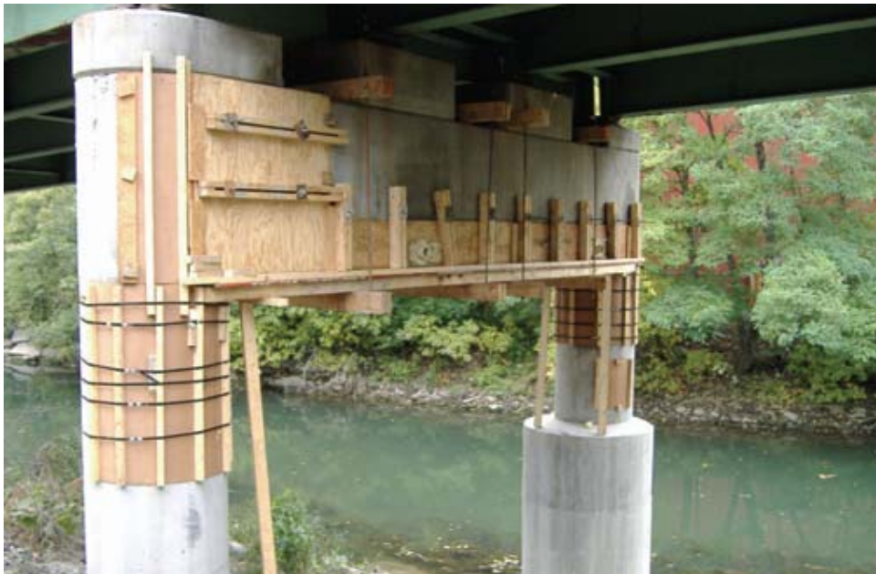
Εικόνα 11 – Καλουπωμένη δοκός πριν την σκυροδέτηση με ΑΣΣ [9]
