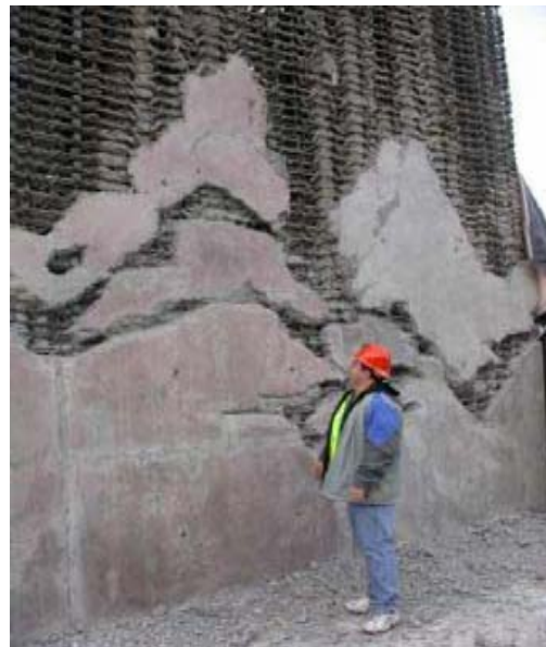
Εικόνες 22, 23 – Αποτελέσματα ύστερα από κακή σκυροδέτηση και δόνηση [4]
