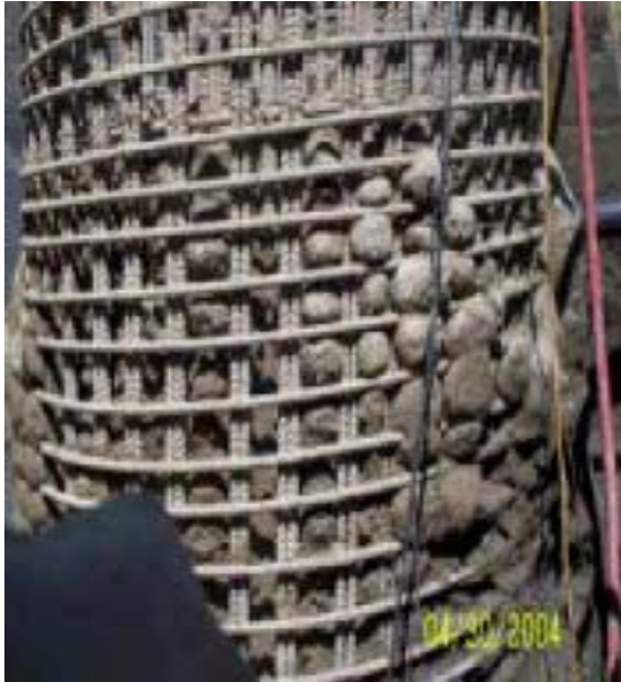
Εικόνες 20, 21 – Αποτελέσματα ύστερα από κακή σκυροδέτηση και δόνηση [4]
