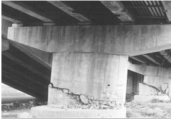
Σχήμα 2.: Αστοχία καμπτικού τύπου.[7]
