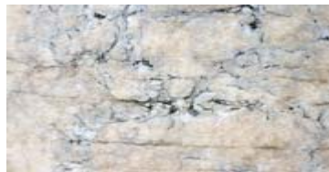
Σχήμα 11 : Αποσάρθρωση και απολεπίσεις [5].
