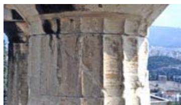
Σχήμα 12 : Διαφορική διάβρωση [5].
