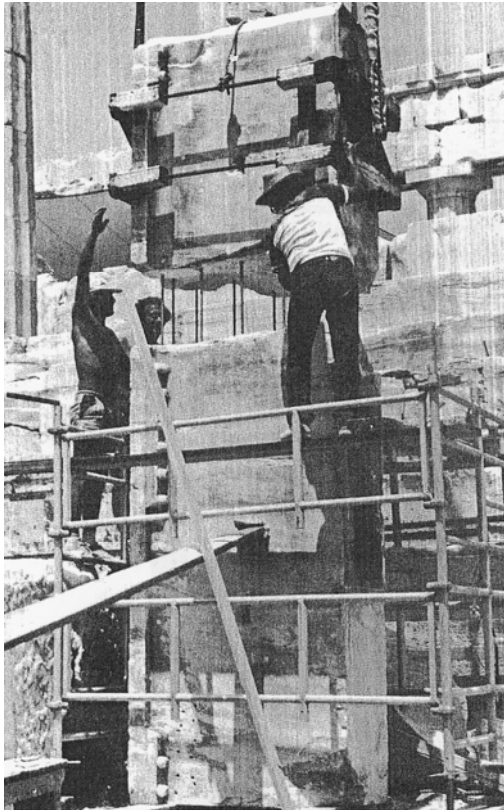
Σχήμα 16: Συγκόλληση δύο τμημάτων του εξωτερικού επιστυλίου με οπλισμούς τιτανίου [8].
