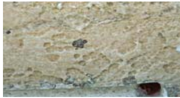
Σχήμα 13 : Κυψελοειδής διάβρωση [5].
