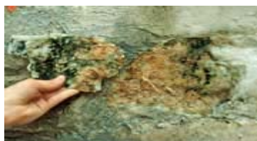
Σχήμα 15 : Βιολογική Φθορά [5].
