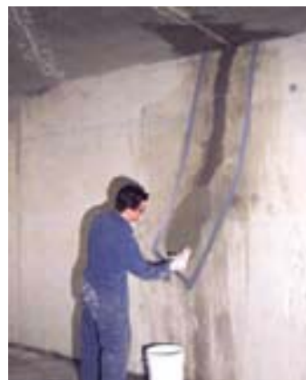
Σχήμα 8: Επικάλυψη της περιοχής με το ημιυδαρές μίγμα τσιμέντου.[10]
