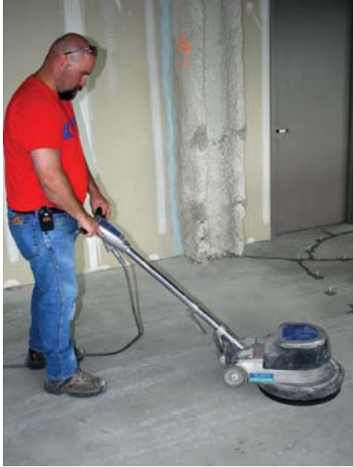
Σχήμα 4: Λείανση της επιφάνειας. [8]
