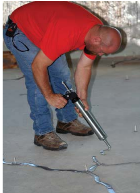
Σχήμα 5: Γέμισμα των ρωγμών με εποξειδική ρητίνη. [8]
