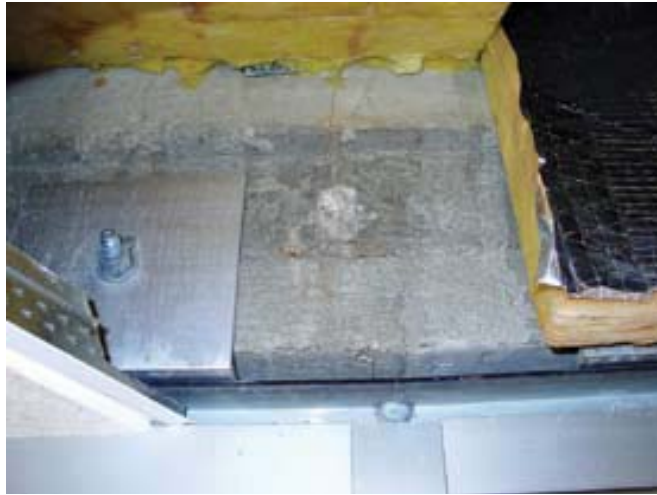
Σχήμα 11: Κατακόρυφη ρωγμή σε σύνδεση. [9]
