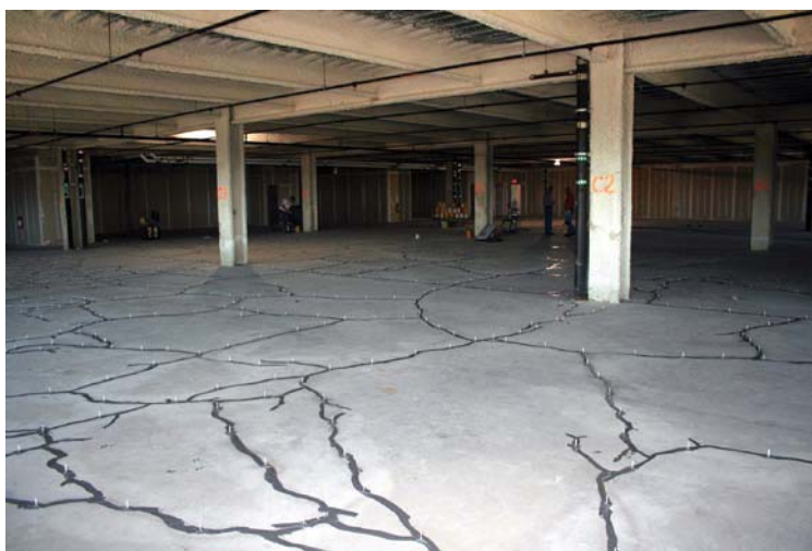
Σχήμα 2: Πάτωμα γκαράζ επισκευασμένο με epoxy injection[8]
