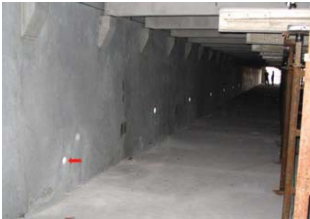
Σχήμα 16: Εσωτερική όψη των πάνελ. Είναι ορατοί οι πυρήνες. Μέσω αυτής στάλθηκαν τα παλμικά σήματα. [14]
