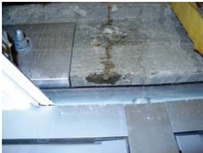
Σχήμα 12: Η ίδια ρωγμή διαρρέει.[9]
