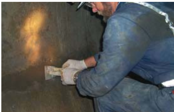
Σχήμα 7: Γέμισμα της ρωγμής με το ειδικό κονίαμα [10]
