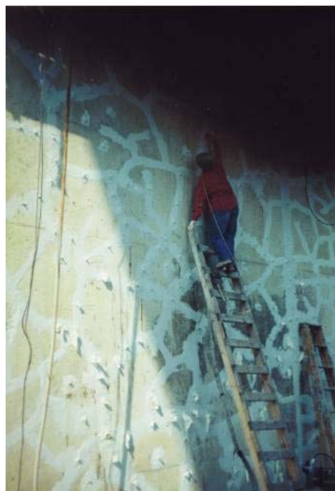
Σχήμα 3: Τοίχος επισκευασμένος με epoxy injection.[7]
