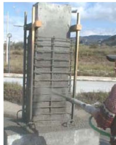
Σχήμα 6.7 : Ενίσχυση με μανδύα εκτοξευόμενου σκυροδέματος.[10]
