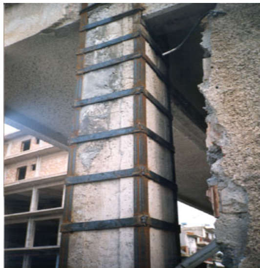
Εικόνα 3.2: Επέμβαση με μεταλλικό κλωβό.[13]
