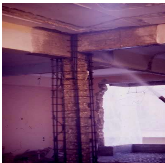
Εικόνα 3.3: Ενίσχυση υποστυλώματος με μανδύα οπλισμένου σκυροδέματος.[13]
