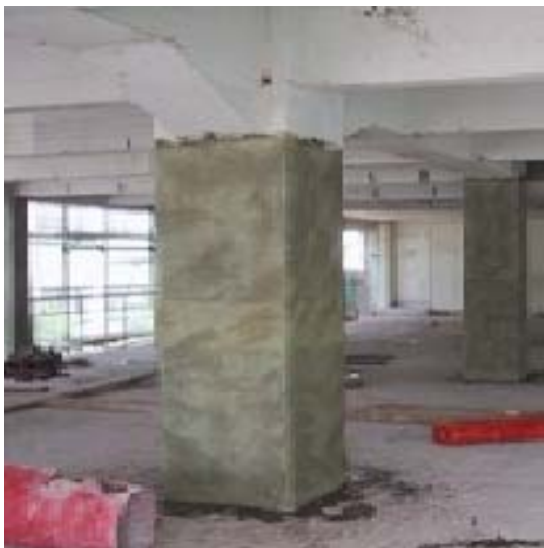
Εικόνα 3.1: Περίσφιξη με ολόσωμο μανδύα από FRP.[13]
