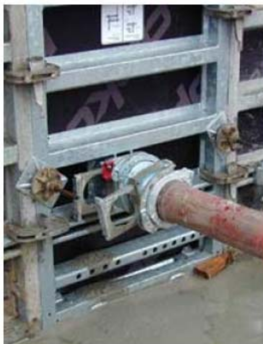
Εικ. 2 – Λεπτομέρεια σκυροδέτησης μέσω εισπίεσης [8]
