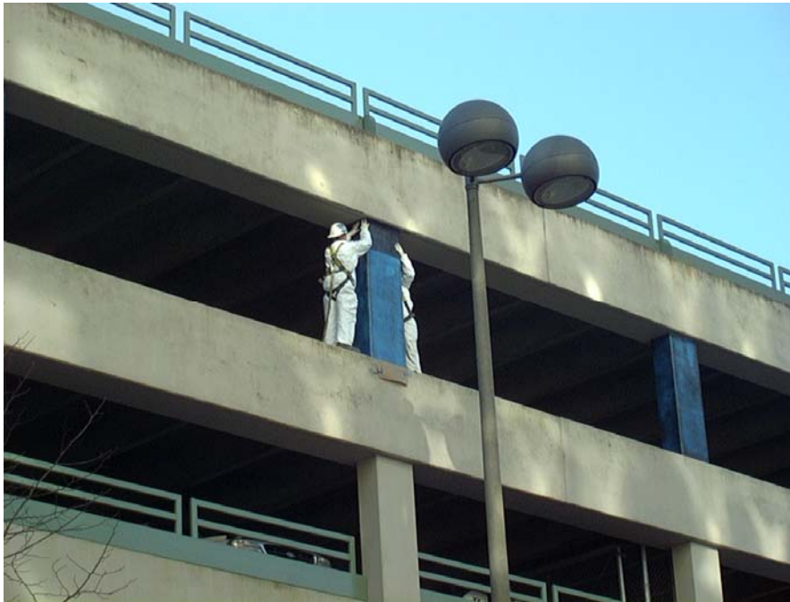
Εικόνα 2: Ενίσχυση υποστυλωμάτων με περιτύλιξη με ινοπλισμένα πολυμερή από ανθρακονήματα. [7]
