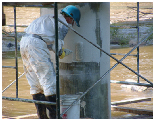
Εικόνα 5β: Στο ίδιο υποστήλωμα τοποθετείται γκρι χρωματισμός για να ταιριάζει με το σκυρόδεμα του υποστυλώματος. [8]
