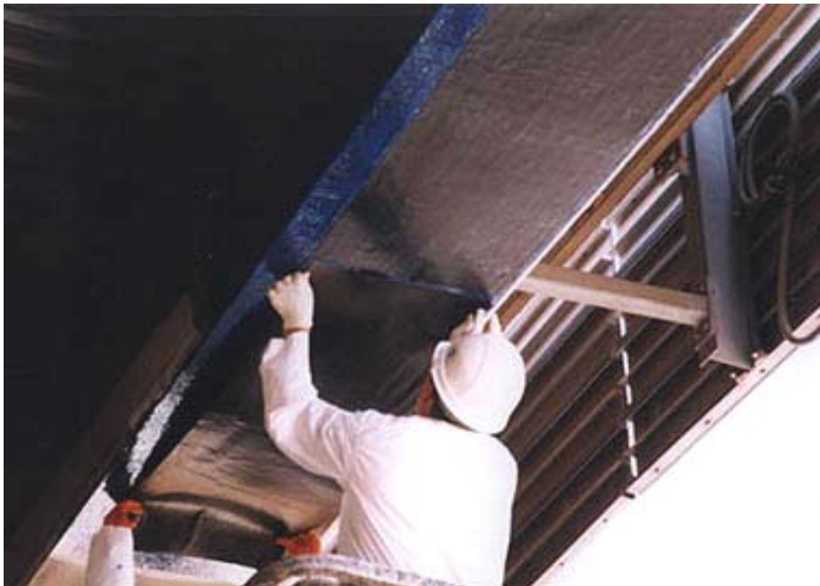
Εικόνα 7: Ενίσχυση δομικού μέλους με ελάσματα από σύνθετα υλικά από ινοπλισμένα πολυμερή. [9]
