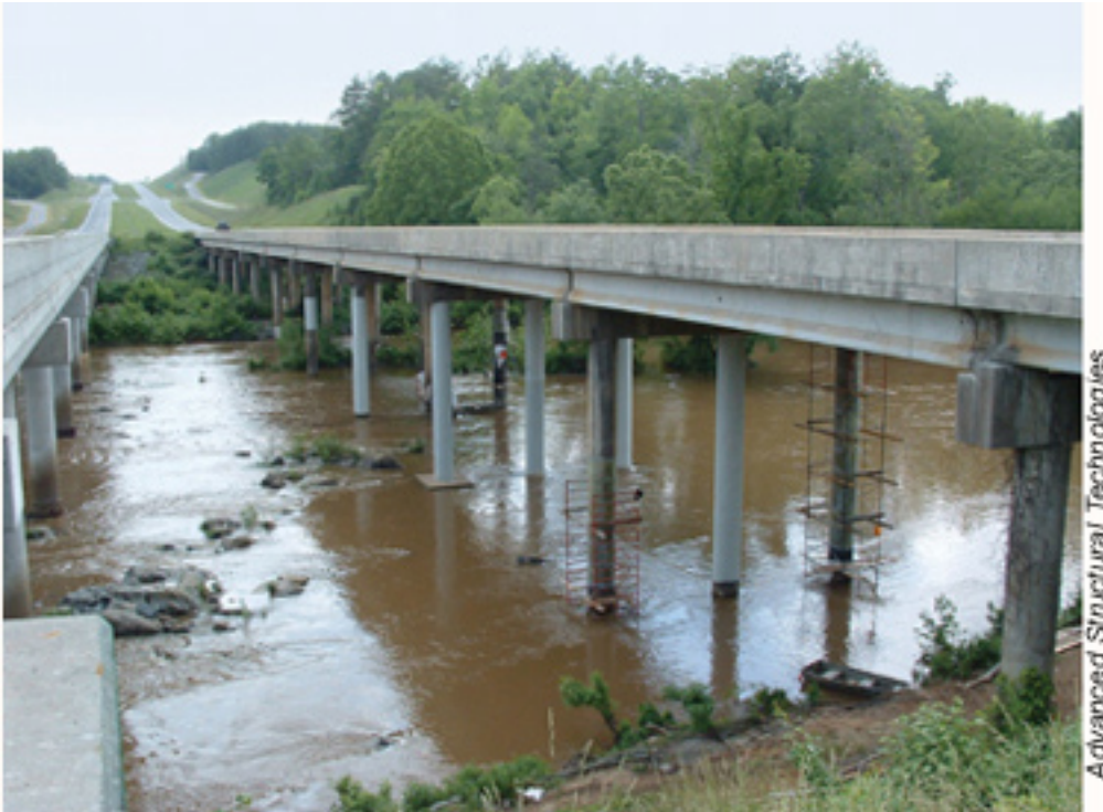
Εικόνα 6: Αυτή η όψη της γέφυρας (Chatham County bridge) είναι στα τελικά στάδια περικάλυψης με ινοπλισμένα πολυμερή και τα στάδια του βαψίματος. Η ολοκληρωμένη εργασία διακρίνεται από το ανοιχτό γκρι χρώμα. [8]
