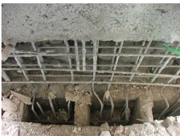
Φωτ.5: Μανδύας από εκτοξευόμενο σκυρόδεμα.
