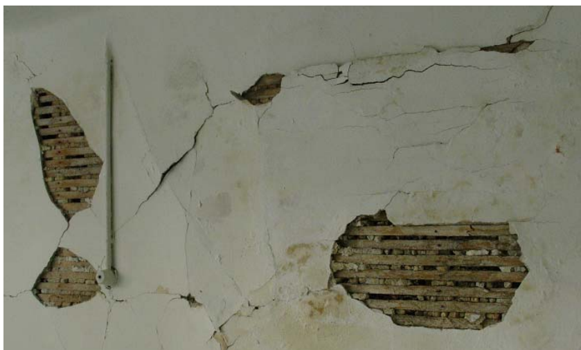
Φωτ.3: Οροφή ισογείου.
