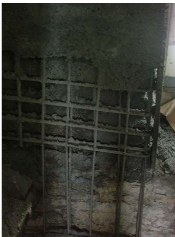
Φωτ.6: Μανδύας από εκτοξευόμενο σκυρόδεμα
