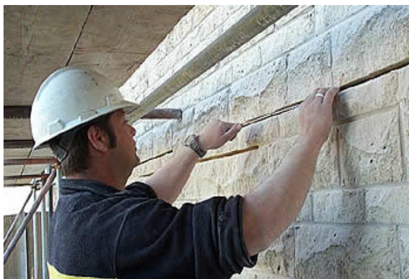
Εικ.19 Εισαγωγή ράβδου σε λιθοδομή [7]
