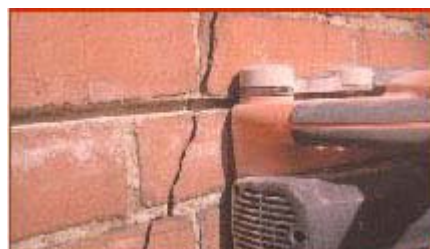
Εικ.8 - 9 Απομάκρυνση κονιάματος εκατέρωθεν της ρωγμής με τροχό [7,11]
