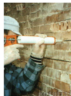
Εικ.18 Εισαγωγή ενέματος [10]
