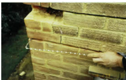
Εικ. 16. Εισαγωγή ράβδου σε γωνία τοίχου [7]
