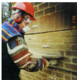
Εικ.8 - 9 Απομάκρυνση κονιάματος εκατέρωθεν της ρωγμής με τροχό [7,11]
