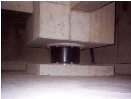
Σχήμα 9. α,β. α) Εφέδρανο LRB – Κτήριο Μουσείου Δυτικής Τέχνης (Τόκιο, Ιαπωνία), β) Δικαστικό Μέγαρο SAN BERNARDINO CALIFORNIA (1986). Το πρώτο σεισμικά μονωμένο κτίριο στις ΗΠΑ (1986) 98 HDRB 5-όροφοι. Διαστάσεις: 125 m x 33 m. {5}
