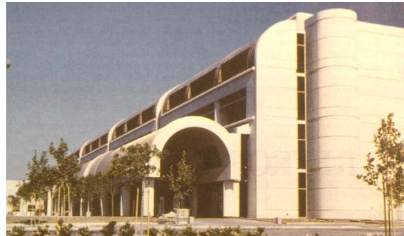
Σχήμα 9. α,β. α) Εφέδρανο LRB – Κτήριο Μουσείου Δυτικής Τέχνης (Τόκιο, Ιαπωνία), β) Δικαστικό Μέγαρο SAN BERNARDINO CALIFORNIA (1986). Το πρώτο σεισμικά μονωμένο κτίριο στις ΗΠΑ (1986) 98 HDRB 5-όροφοι. Διαστάσεις: 125 m x 33 m. {5}
