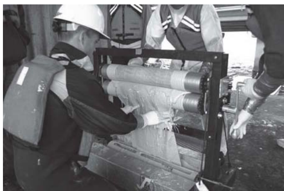
Σχήμα 3: Εφαρμογή και τοποθέτηση FRP κατά το σύστημα wet lay-up. [6]
