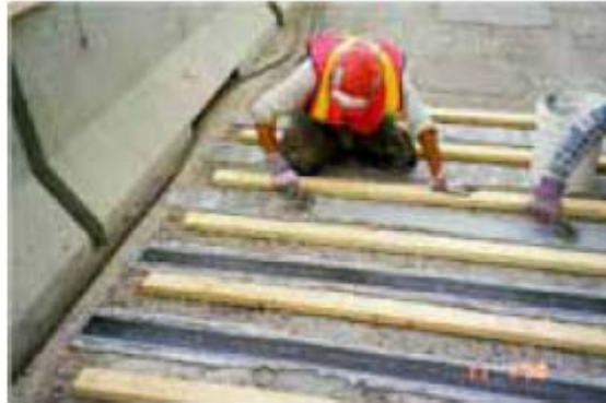
Σχήμα 10: Ενίσχυση καταστρώματος της γέφυρας Country Hills Boulevard.[4]
