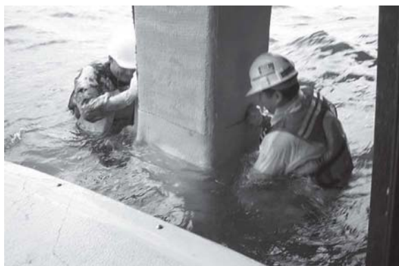
Σχήμα 2: Εφαρμογή και τοποθέτηση FRP κατά το σύστημα pre-preg. [6]
