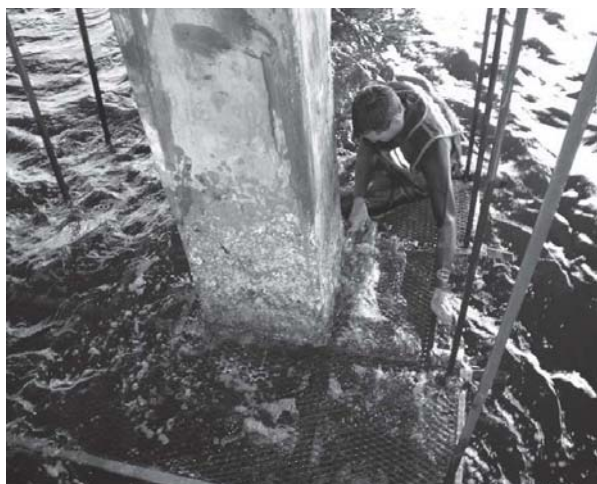
Σχήμα 1: Σύστημα σκαλωσιάς. [6]
