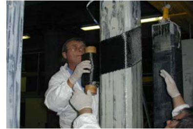
Σχ.6: Τοποθέτηση υφάσματος
