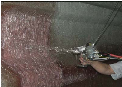
Εικόνα 3: Εφαρμογή της μεθόδου SFRP σε δοκό [11]
