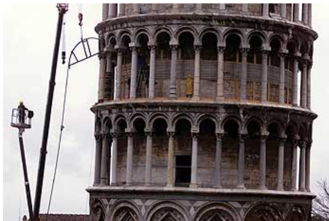
Εικόνα 11 : Τοποθέτηση Προστατευτικών και Καλωδίων στην Ανωδομή του Πύργου, πριν αρχίσουν οι Διαδικασίες Εκσκαφής
