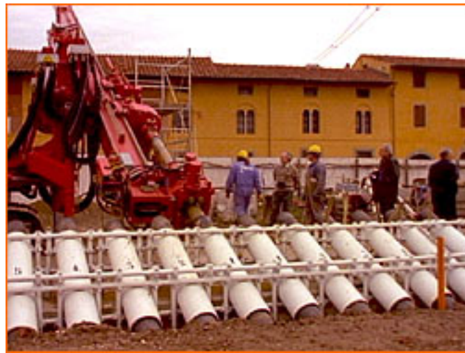
Εικόνα 13 : Τα Γεωτρύπανα που χρησιμοποιήθηκαν για την Εφαρμογή της Μεθόδου Αφαίρεσης Εδάφους
