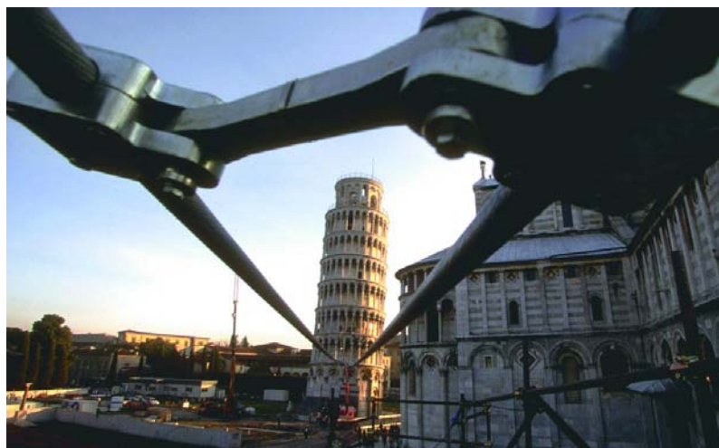
Εικόνα 6 : Στήριξη της Κατασκευής Μέσω Τενόντων (Reuters)
