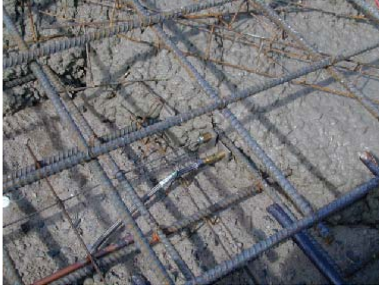
φωτογραφία 5 τοποθέτηση δικτύου αισθητήρων κατά τη διάρκεια σκυροδέτησης[4]
