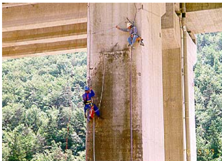
φωτογραφία 3 λεπτομερής επιθεώρηση σε πυλώνα γέφυρας[3]
