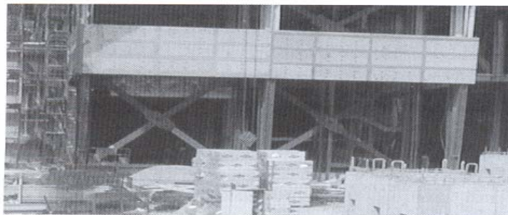
Αντισεισμική ενίσχυση κατασκευής με χιαστί διαγώνιους συνδέσμους
