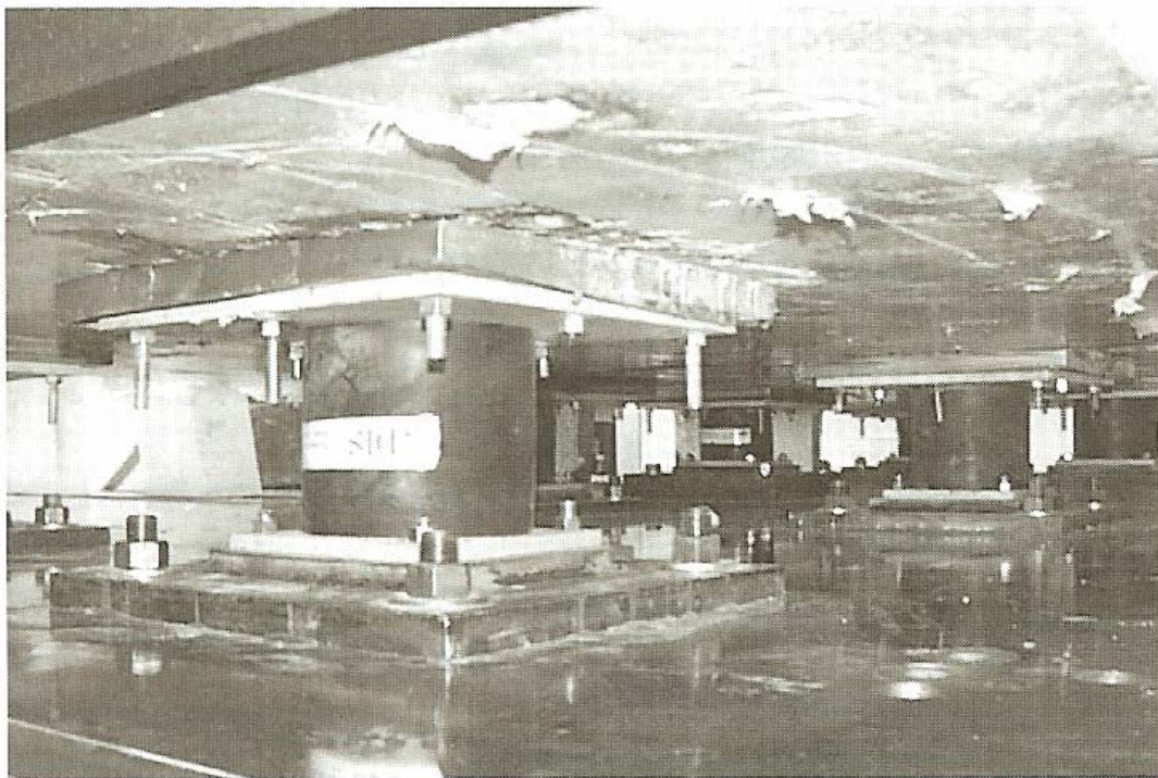
Εικ. 1 Ελαστομεταλλικό εφεδρανο - ELB
