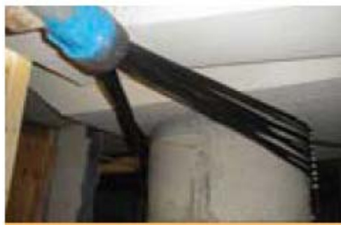
Σχήμα 1: Λεπτομέρεια τοποθέτησης τενόντων 7
